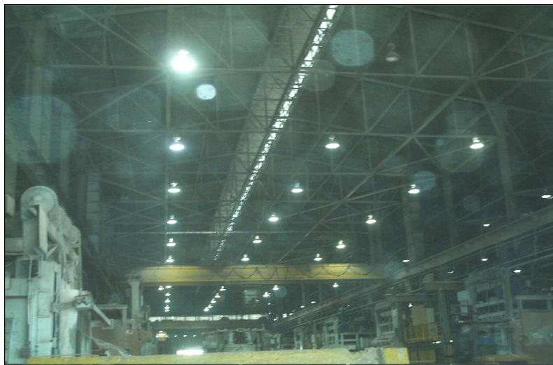
Figura 3.1. Estructuras metálicas.(CVG Ferrominera 2009).
