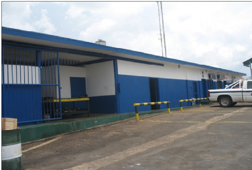
Figura 5.2 Fachada principal de la Planta Compresora Budare.
