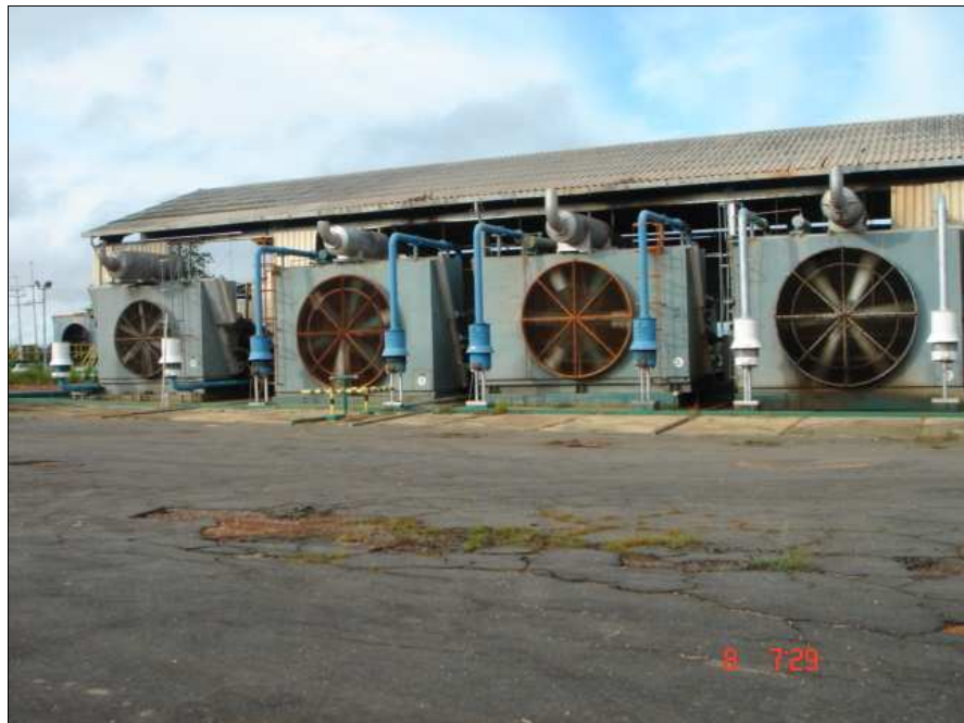
1 FIGURA 2 MOTOCOMPRESORES Y SU GALPÓN.
