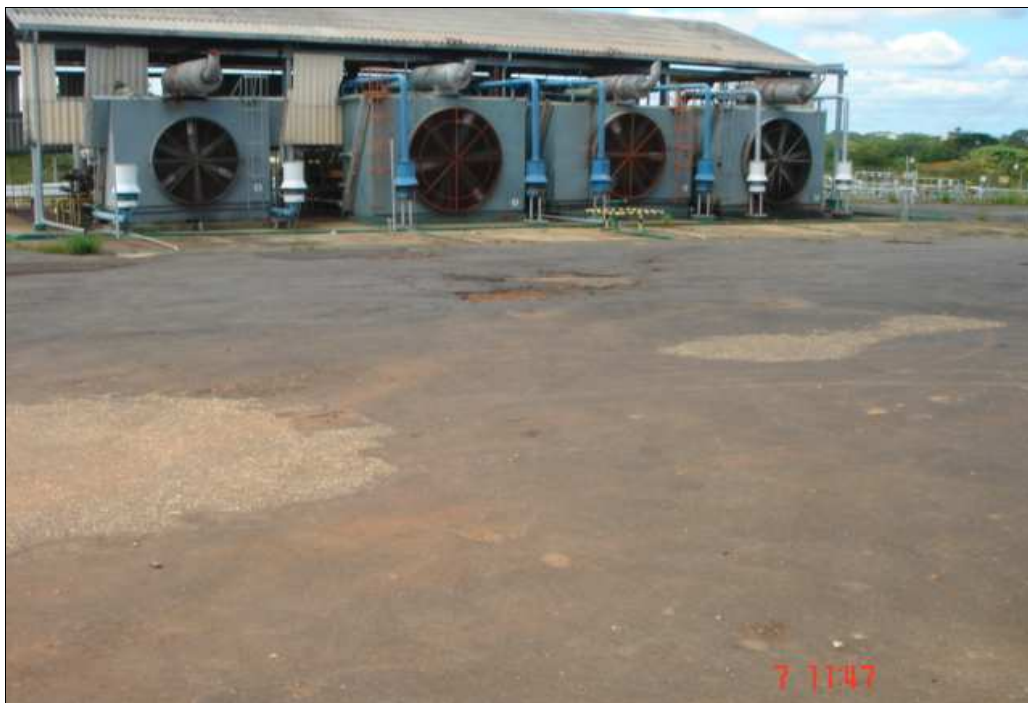
Figura 6.8 Partes con pavimento sin huecos, pero muy desgastado.
