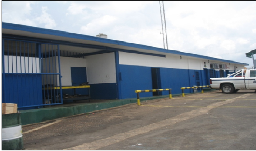
Figura 2.1 Infraestructura de la Planta Compresora Budare.
