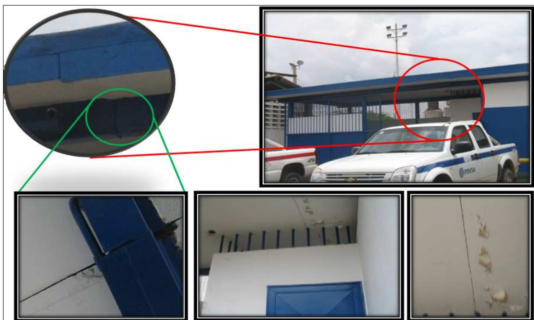
Figura 5.14 Ubicación y detalles de junta.
