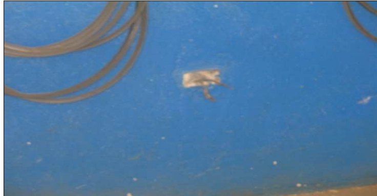
Figura 5.3 Ausencia de cajetín en zona de taller.
