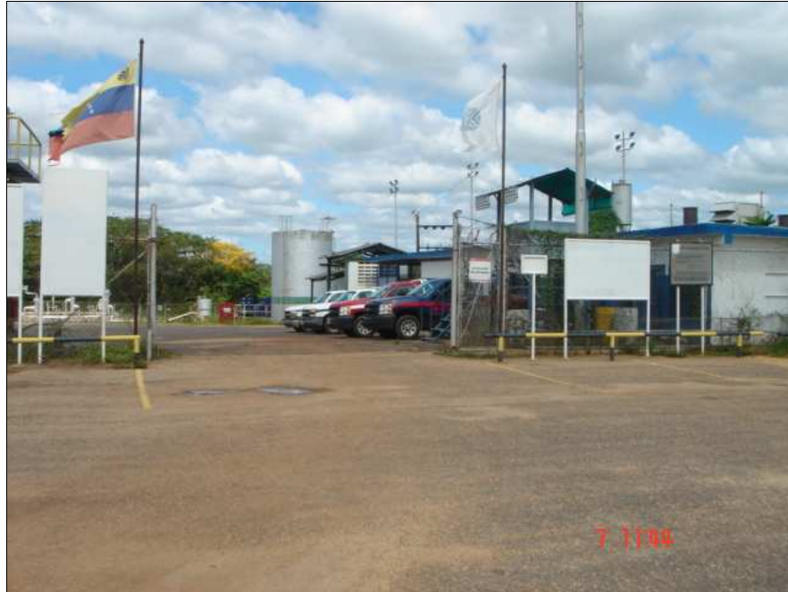
1 FIGURA 3 ACCESO PRINCIPAL A LAS INSTALACIONES.
