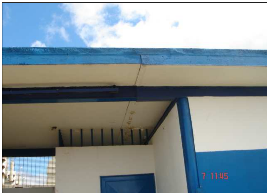
1 FIGURA 4 JUNTA DE TECHO, SOBRE TALLER.
