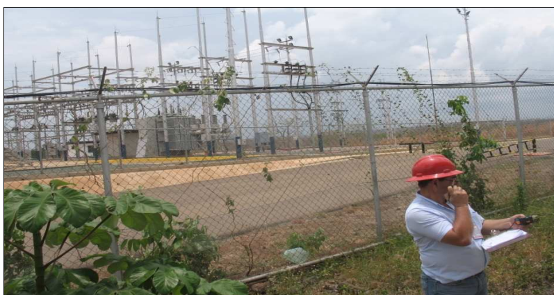
Figura 5.7 Cerca perimetral con arbustos y maleza.
