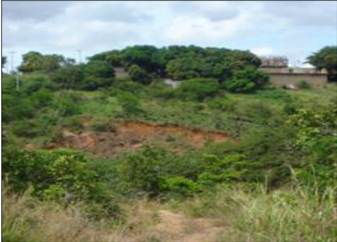
Figura 5.1 Escarpes erosivos de la Formación Mesa.
