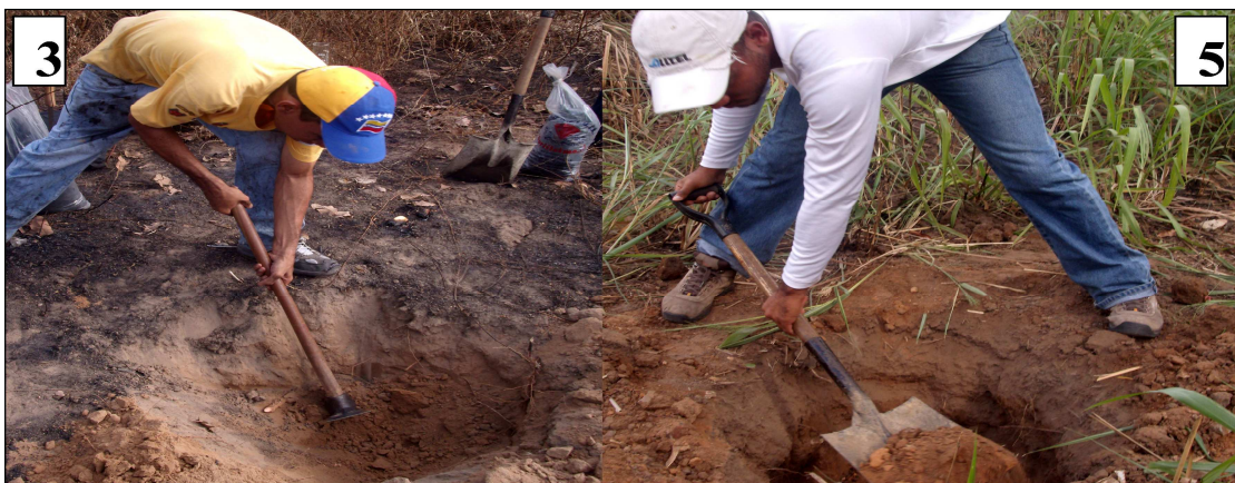
Figura 4.3 Calicatas 3 y 5 correspondientemente (González y Tirado, 2010).
