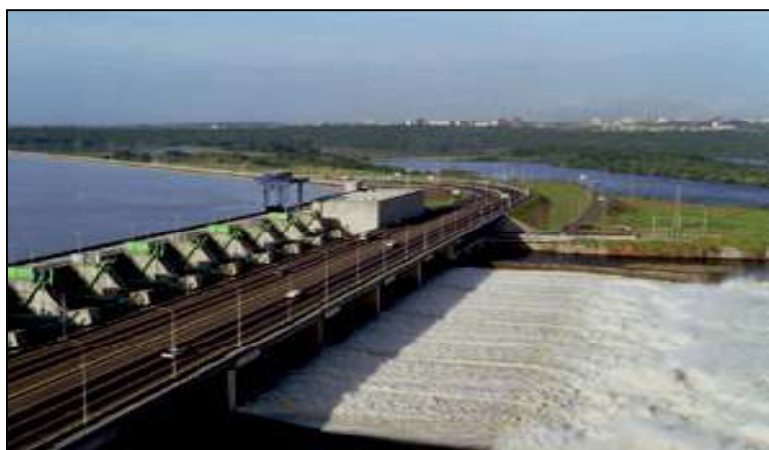
Figura 2.2. Central hidroeléctrica Antonio José de Sucre II(Internet-pág. EDELCA).
