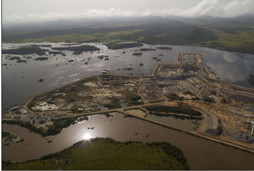
Figura 2.10 Vista Aérea del Proyecto Hidroeléctrico Tocoma. (EDELCA).
