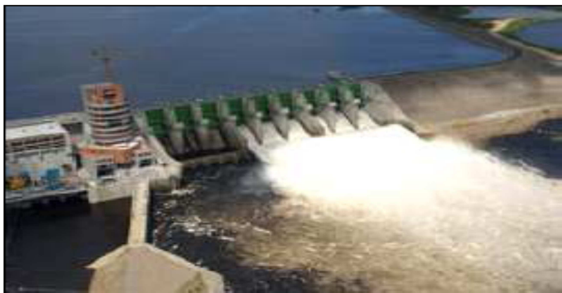
Figura 2.3. Central hidroeléctrica Francisco de Miranda (Internet-pág. EDELCA).
