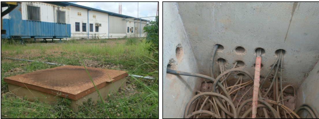
Bancadas y Ductos
