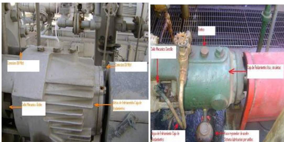
Figura N° 4.26 Diferencia básicas entre una bomba 8 va (G-2001 A) Edición API 610 y una de 5 ta (J-7) Edición
