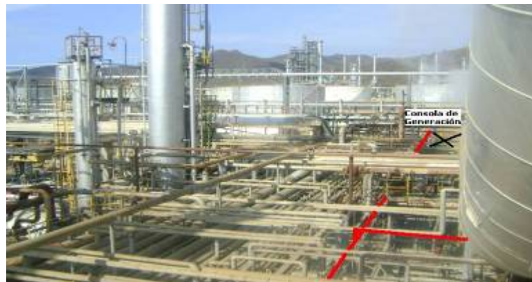
Figura N° 4.14 Vista superior de la parte este de la unidad de FCC.
