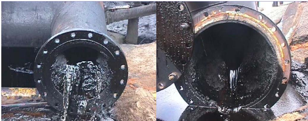
**Figura 2.15. Limpieza de arena en Oleoductos y tuberías.**
