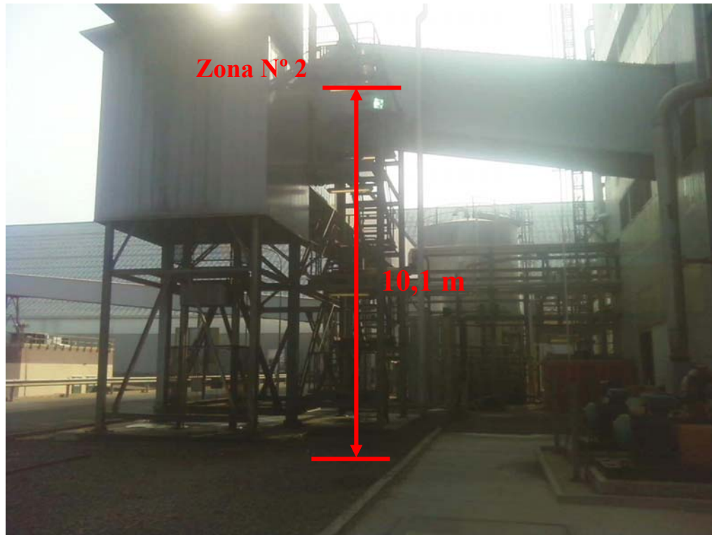
Figura 3.7. Inicio de la galería de la cinta transportadora [12].
