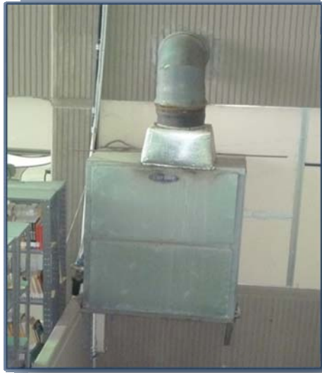
Figura 3.8. Unidad CARRIER , modelo: 38AK-O12-511 perteneciente al área crítica objeto de estudio.
