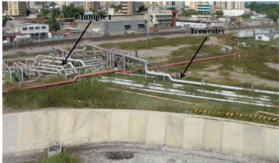
Figura 1.4. Área de trabajo (Sección del patio de tanques de almacenamiento, recibo y carga en la Refinería Puerto la Cruz)
