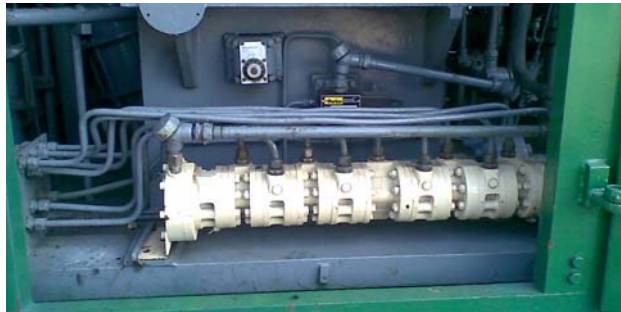
Figura 4.9. Vista posterior del divisor de flujo instalado en la turbina de gas.
