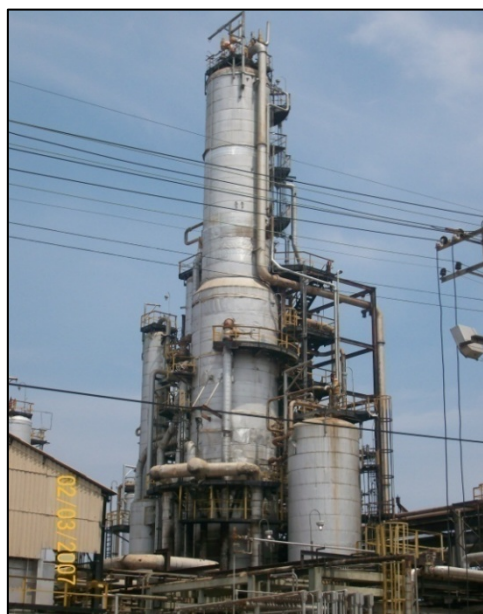
Figura 2.16 Torre de Destilación Atmosférica DA-1
