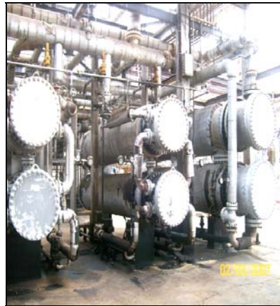
Figura 2.7. Intercambiadores de calor tipo tubo-carcaza
