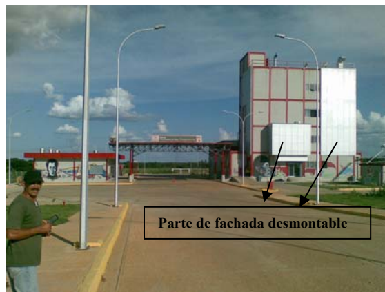
Figura 4.12: Fachada de la infraestructura de la Planta “Chaguaramas”.
