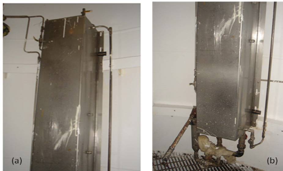
Figura 2.13. Depósito de aceite del sistema hidráulico de la Monoboya: (a) Parte Superior y (b) Parte inferior
