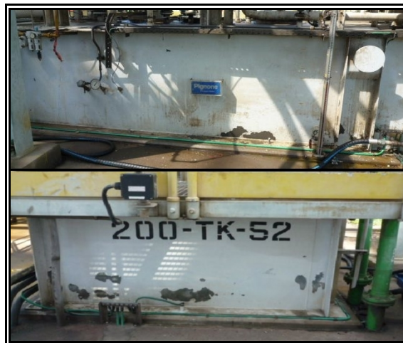
Figura 4. 4. Tanque del sub-sistema de lubricación.
