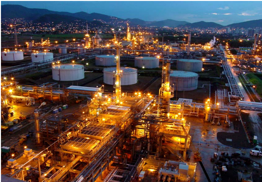
Figura 1.2. Vista panorámica de las instalaciones de la RPLC.
