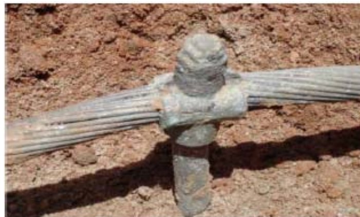
Figura 4.7. Conexión exotérmica de los conductores.
