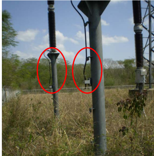
Figura 4.9. Conexión de Tierra cortada en las copas terminales asociadas a la línea 400KV de José
